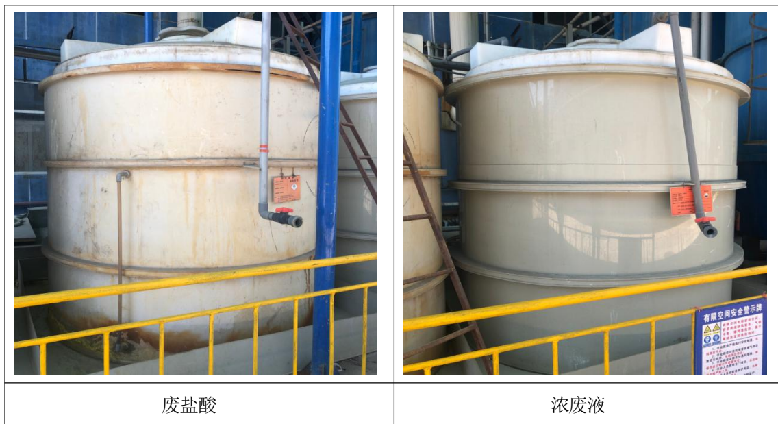
图3-1 地表储罐现场踏勘情况
