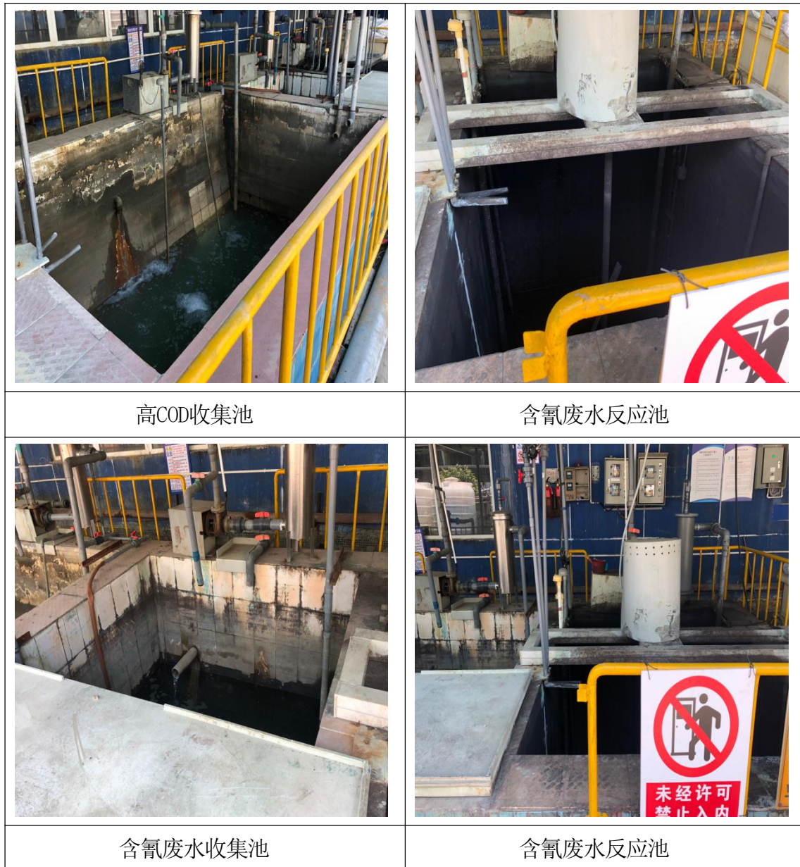
图3-3 水坑或渗坑场踏勘情况
