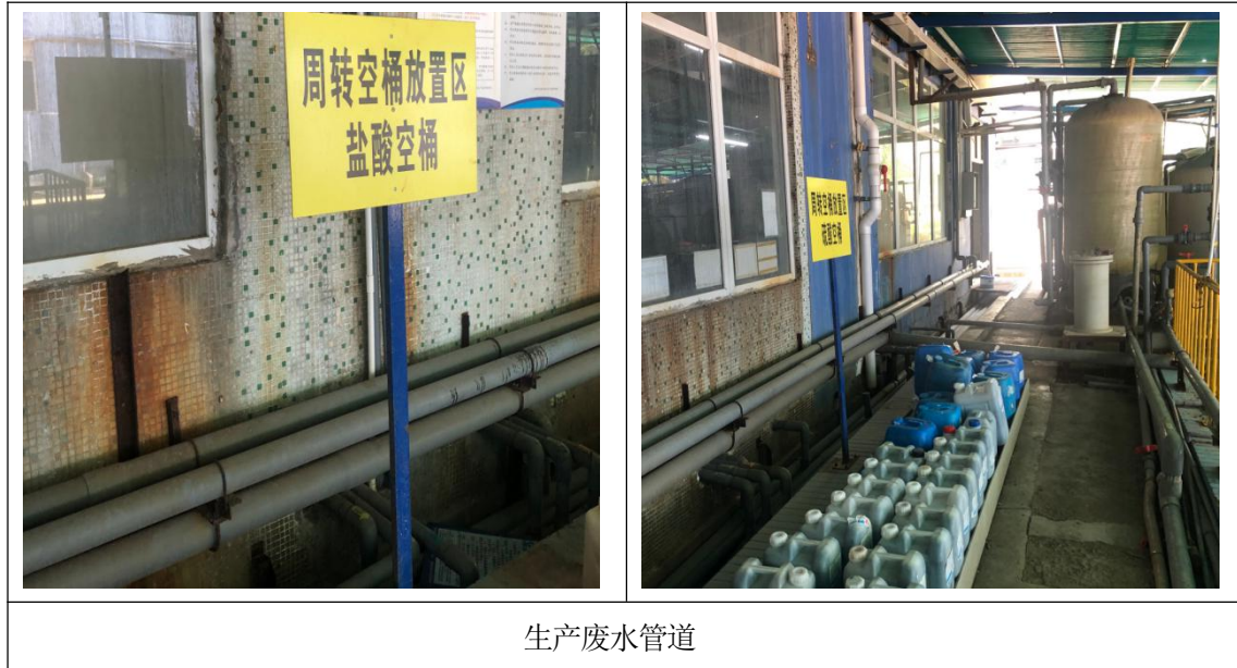
图3-5 管道运输踏勘情况
